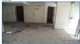
Picado de losa para intervenir enfierradura, Sector de Guardia de Módulo Agrupación 47-50
