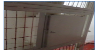
Sello de escotillas Cajas de Escalera y Shaft de Basura, a solicitud de GENCHI.
